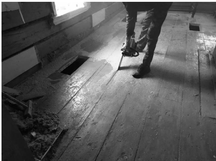
**Рис. 3. Выпиливание заготовок из досок половой конструкции**
