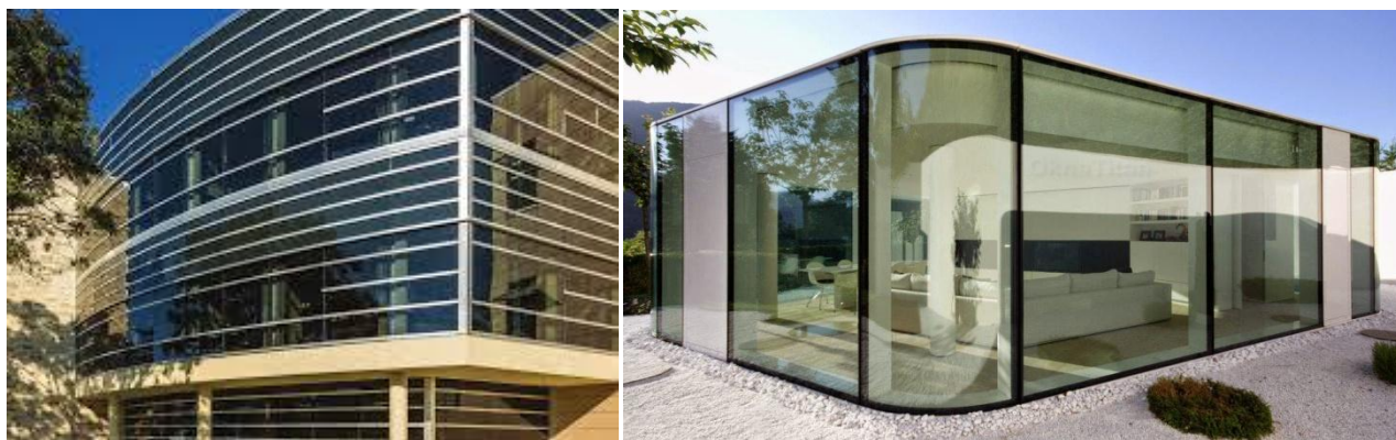
Рис. 1. Применение гнутых светопрозрачных ограждающих конструкций
