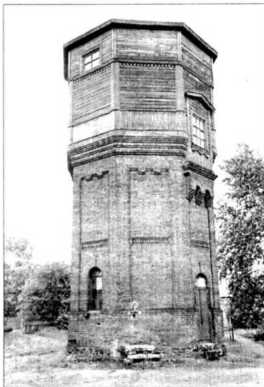
Рис. Водонапорная башня в Нее. Фото 2002 г.
